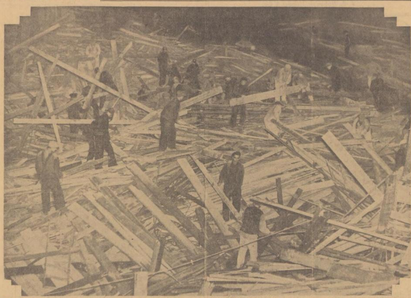
Två stora byggnadstäckningar vid Johanneshov i nio våningars höjd vräktes omkull av den kraftiga stormen på torsdagen. Som genom ett under lyckades alla arbetare undkomma vid rasen, trots att en del av dem utsattes på ställningen. Den stora stormen ställde också till en hel del andra skador i staden. Se sidan elva, spalt två.
